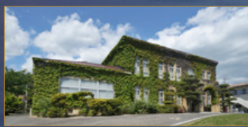
長島愛生園歴史館(旧事務本館)
